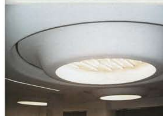
Glatt und rund. Um eine gleichmäßige Oberfläche zu gewinnen, wurden die Fugen unter Zuhilfenahme einer PVC-Schablone vollflächig im Q4-Qualität verspachtelt.
