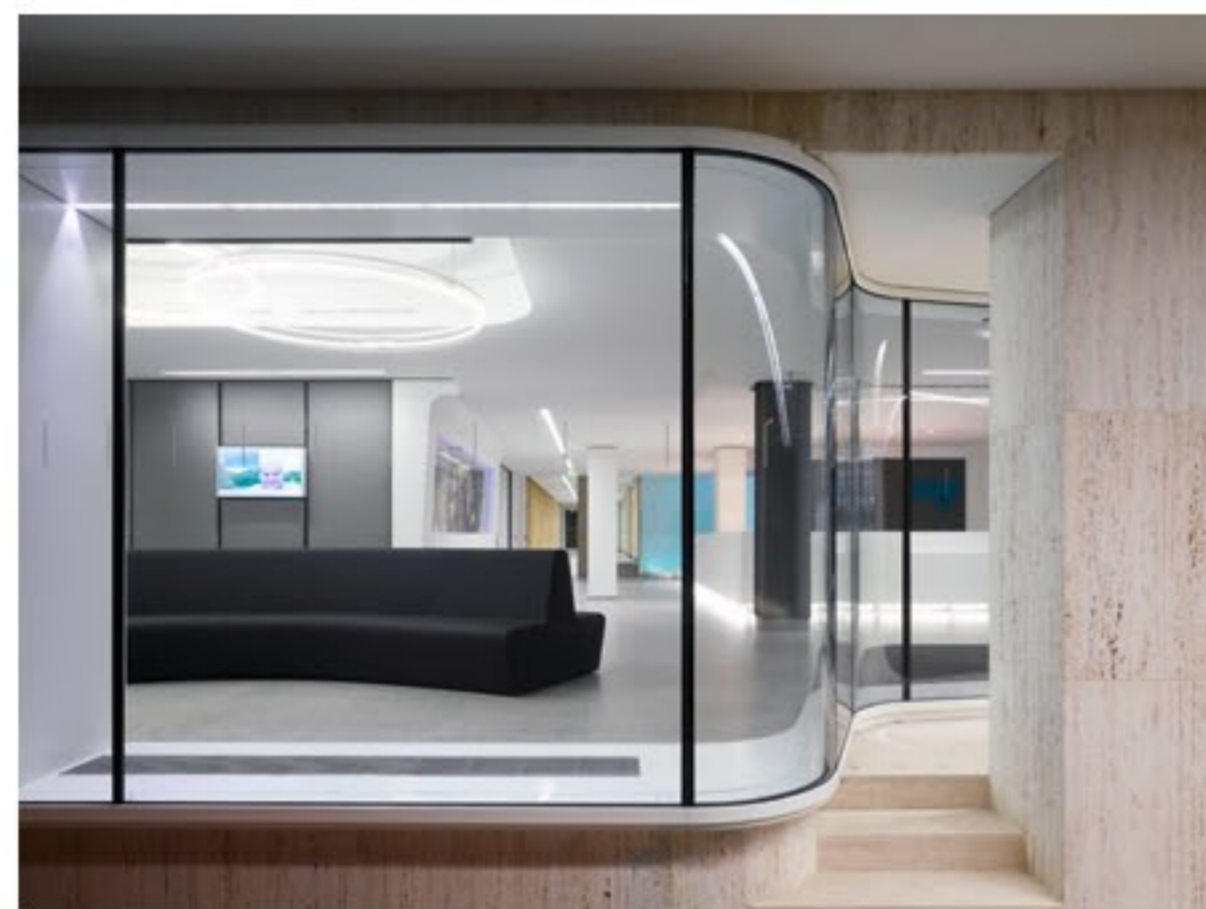
Die neue Fassade zieht sich elegant rund um die Ecke – zum Glück nicht in polygonalem, glatten, sondern gebogenem Glas.
