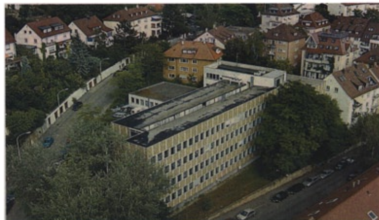
So sah das Bürogebäude aus den fünfziger Jahren vor dem Umbau aus.
