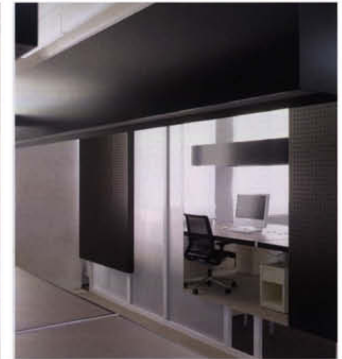
3 Kulissenartige Fassade aus Kunststoffwaben in einfachen Rahmen aus Fichte, vorgehängter perforierter MDF und Spiegelflächen
