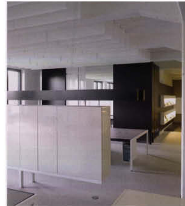
2 Weit auskragende Raumteiler gliedern den Arbeitsbereich auf einem mit Nadelfilz bezogenen Podest. Akustikdecke aus Schaumstofflamellen
