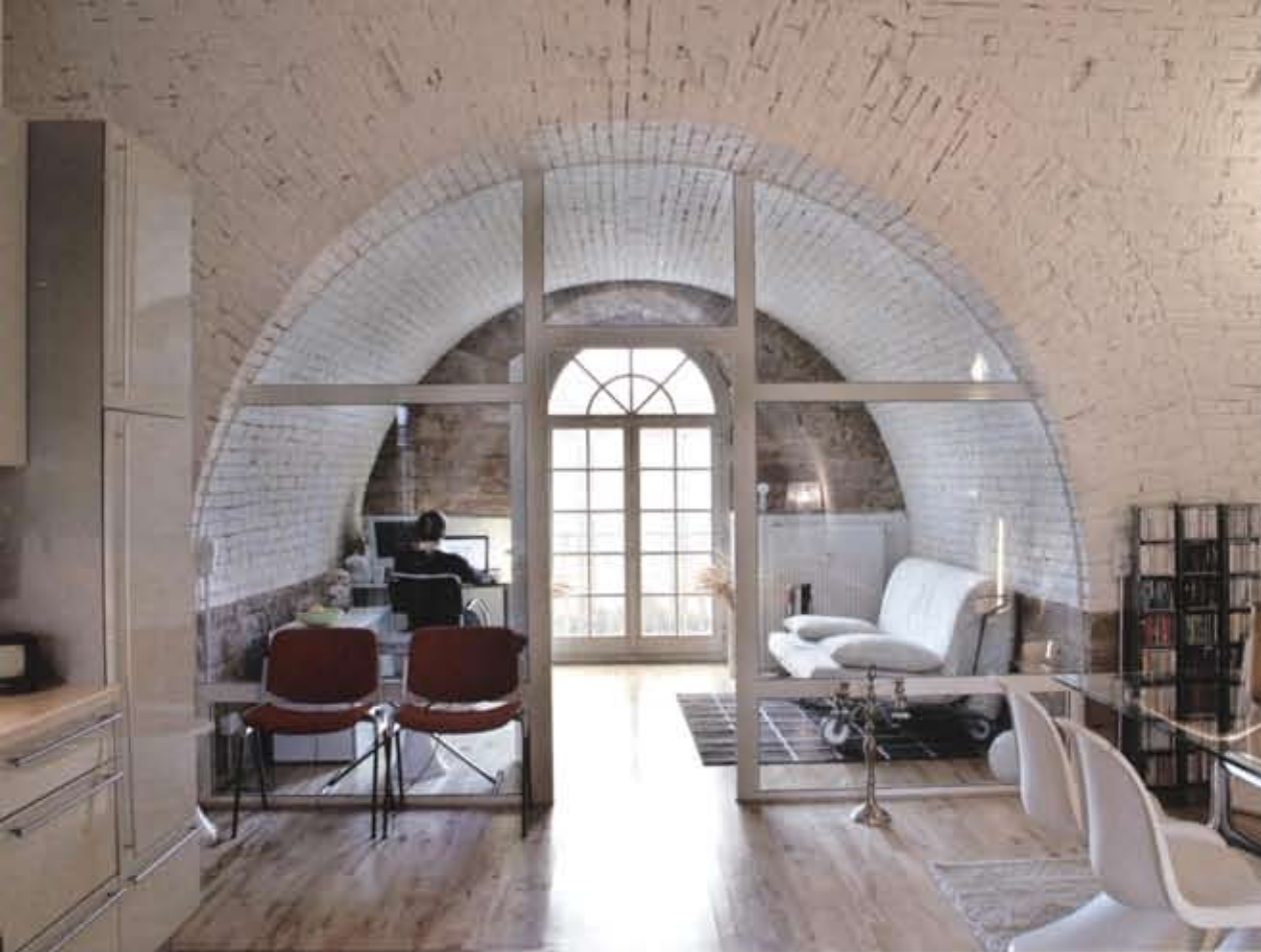
Tonnengewölbe und Tonnendach – um den Altbau zu bewahren, wurde die Elektroinstallation jeweils im Boden verlegt. Links: Umwandlung der ehemaligen Bundesfestung Körnermagazin Rastatt in Wohnungen, Architektur: Rolf Fuhrmann, Rechts: Zollinger Halle in Ludwigsburg, Bottega und Ehrhardt Architekten, Umnutzung eines Industriebaus in Bürostrukturen.
