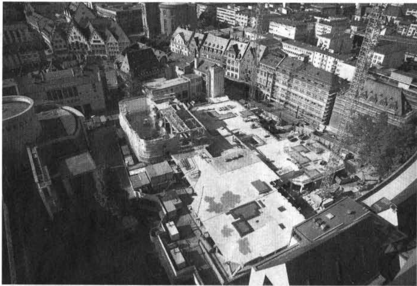
Die „Elefantenfüße“ sind verschwunden: Bis auf das Erdgeschoss ist das Technische Rathaus schon Geschichte.
