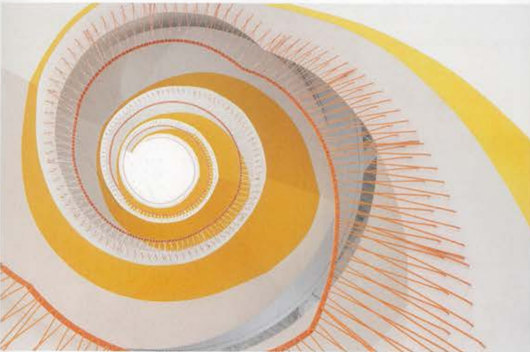
Das zentrale Treppenhaus.
